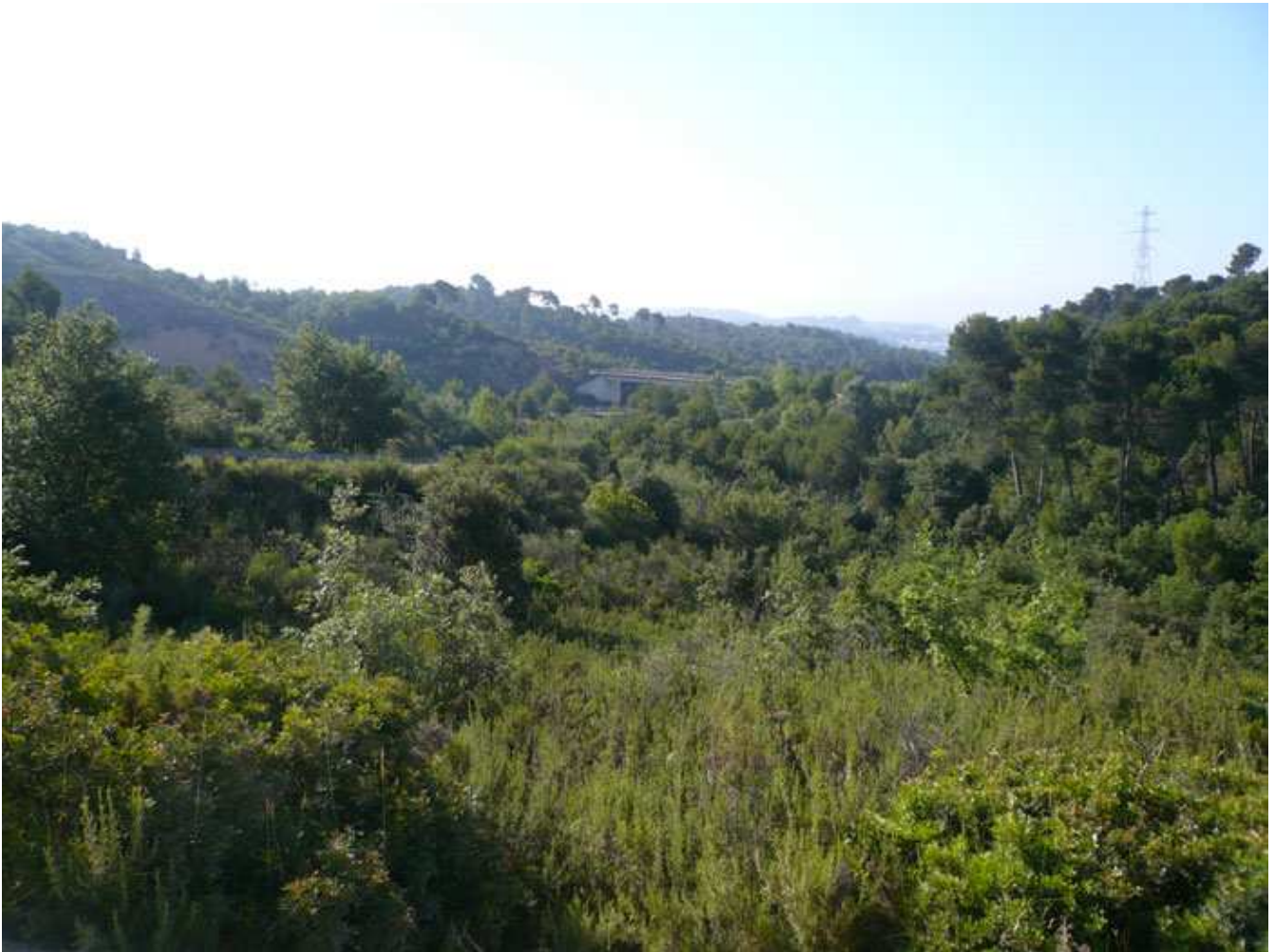
Puente por el que la pista supera la autopista.
